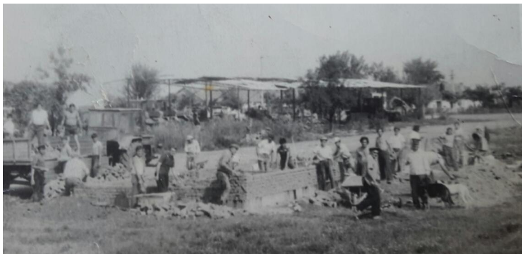
Construcția actualei baze sportive
